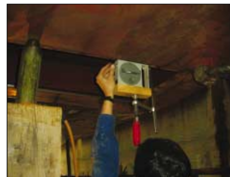
Fig. 4 – Utilização do nível de artilharia durante a montagem da gôndola
