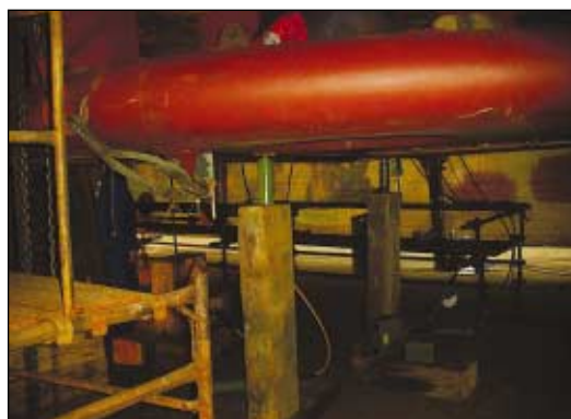
Fig. 3 – Pré-montagem da gôndola
