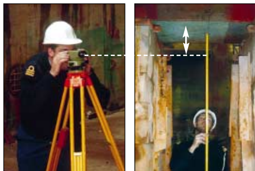
Fig. 2 – Nivelamento da quilha
