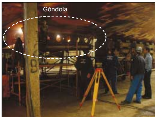
Fig. 5 – Verificação da inclinação durante a ligação soldada
