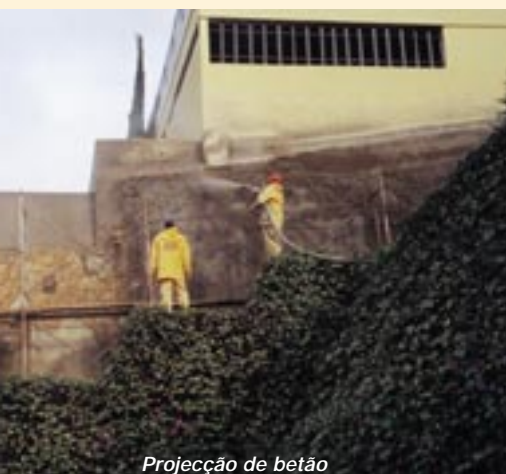
Projeção de betão
