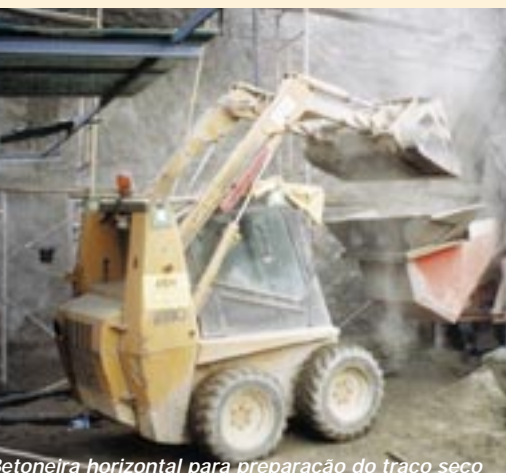
betoneira horizontal para preparação do traço seco
