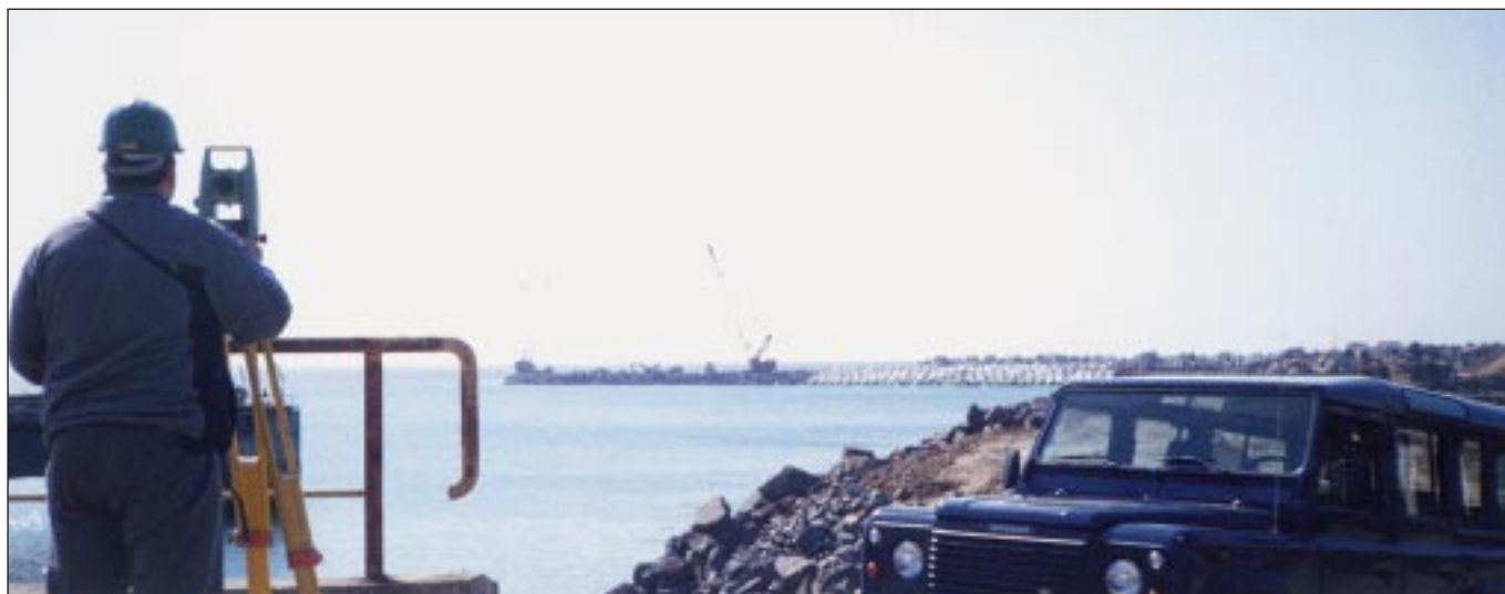
Aquisição de dados topográficos no Terminal XXI
