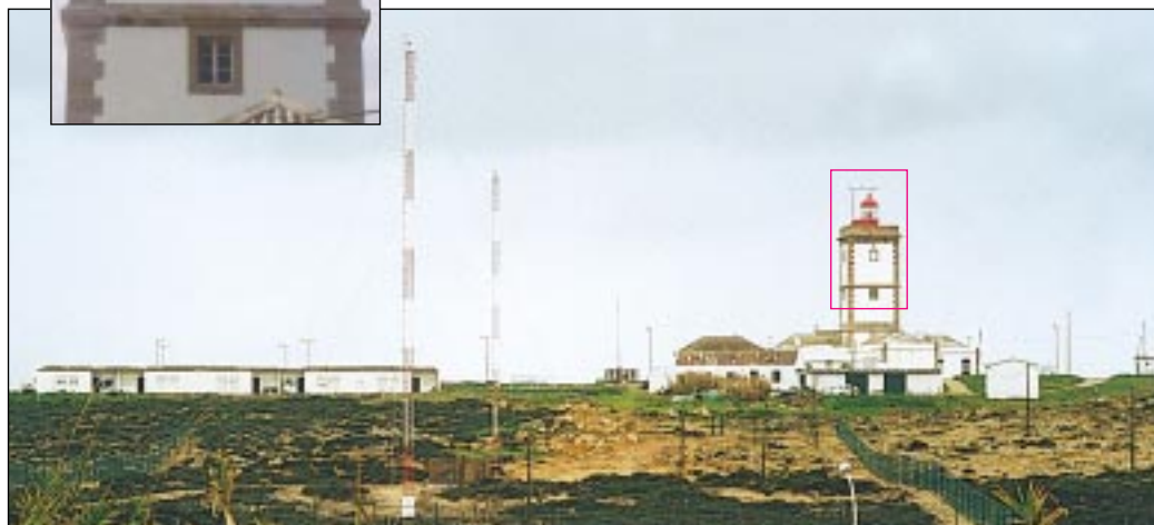
Vista geral da estação e do farol do Cabo Carvoeiro
