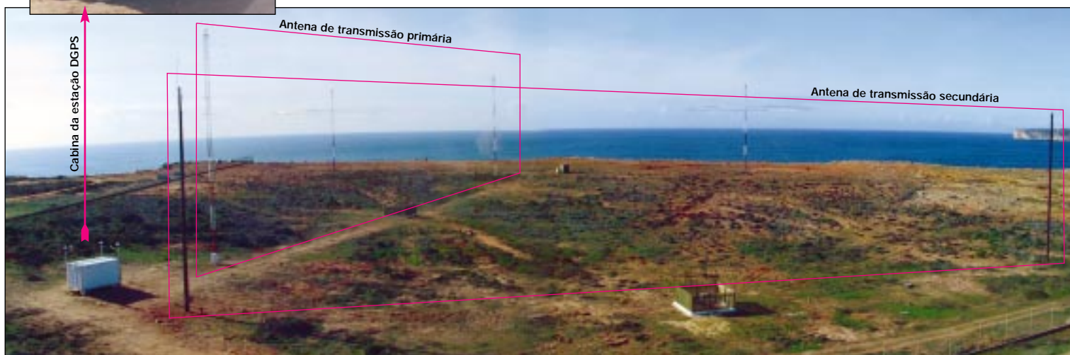
Vista geral da estação de Sagres
