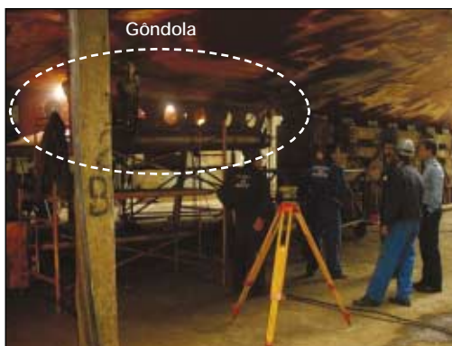
Fig. 5 – Verificação da inclinação durante a ligação soldada
